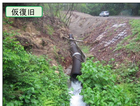
倒木伐採・土砂撤去・コルゲート管設置による用水確保
