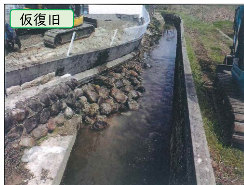
コンクリート殻撤去
